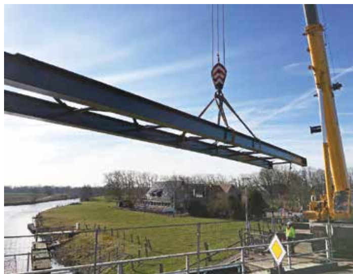
Sanierung der Fußgängerbrücke „Medemschleuse“. Foto Florian Heitsch
